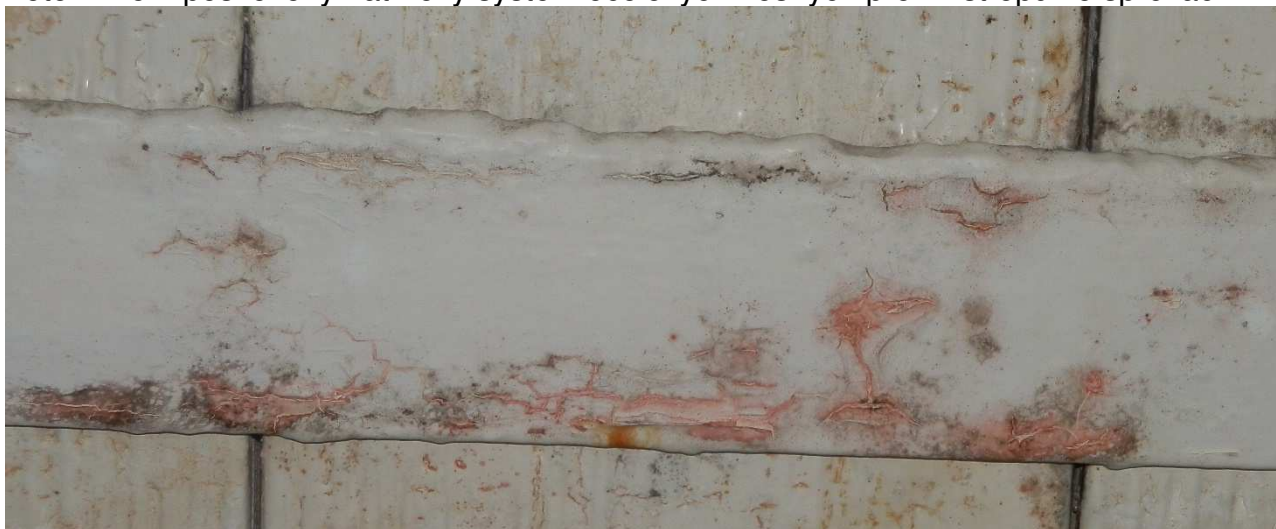
Foto č. 45 – poškozený nátěrový systém ocelových nosných profilů stropu ve sprchách
