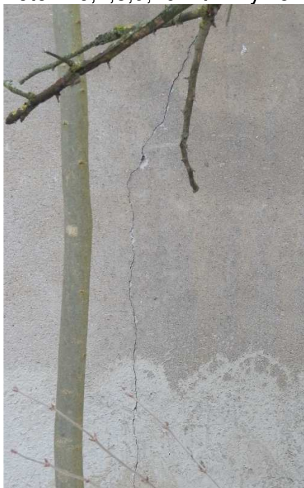
Foto č. 6,7,8,9,10 – trhliny ve fasádě objektu - výběr
