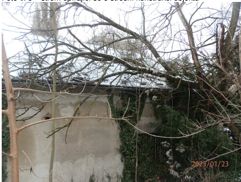
Foto č. 5 – strom opírající se o střešní konstrukci objektu
