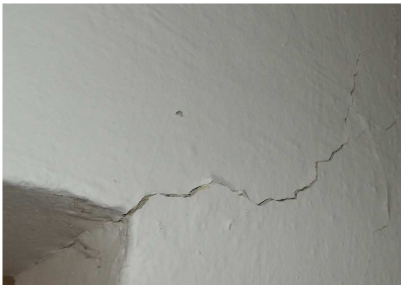
Foto č. 11÷24 – trhliny ve vnitřních prostorách objektu v okolí otvorů - výběr
